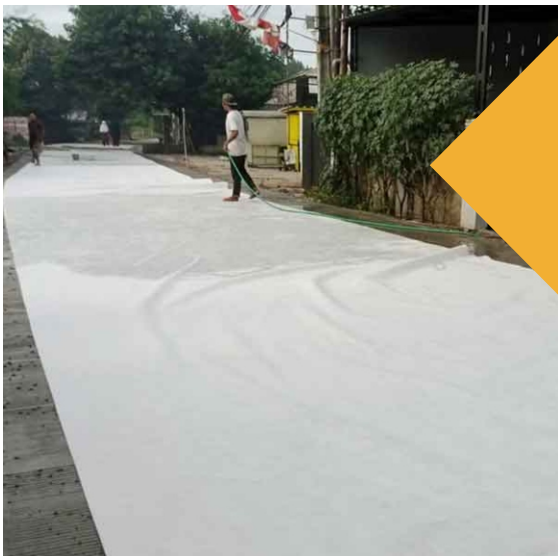
APLIKASI CURING BETON GEOTEXTILE NW 150 PET
